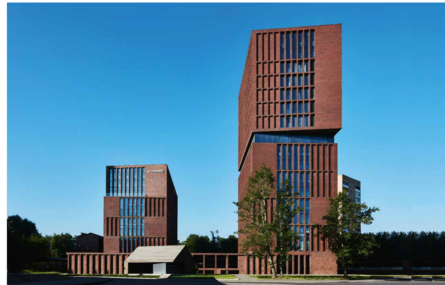
Жилой комплекс EgoDom, Москва, ул. Новоалексеевская. Архитекторы: Сергей Скуратов, Никита Демидов и др., 2017 г.
